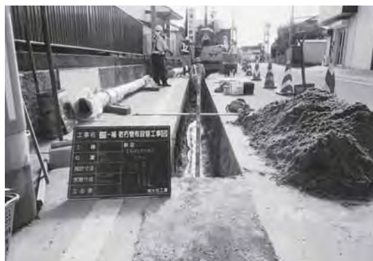
▲耐震化した配水管への敷設替工事
