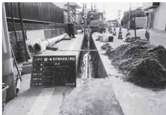
▲耐震化した配水管への敷設替工事
