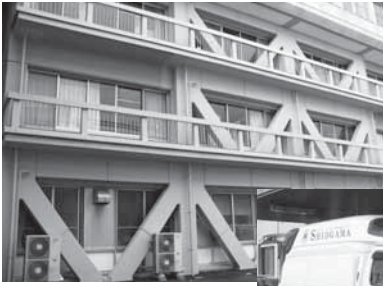
▲病棟の耐震補強工事をしました
