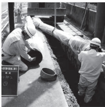
▲老朽配水管の更新では、宮城県沖地震などに備え、耐震管が埋設されています
