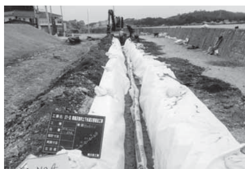
▲災害復旧による配水管の敷設替工事
