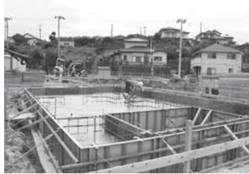
▲建築工事が進んでいます(伊保石地区)
