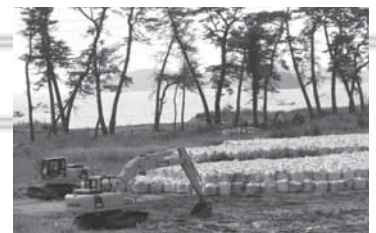
▲盛り土の搬入が進んでいます(桂島)
