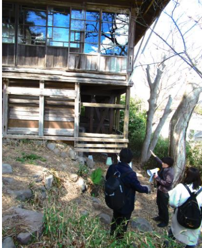
動物侵入を防ぎ、書院の東側を支える懸造（かけづくり）部分が補強された（4月10日）→
