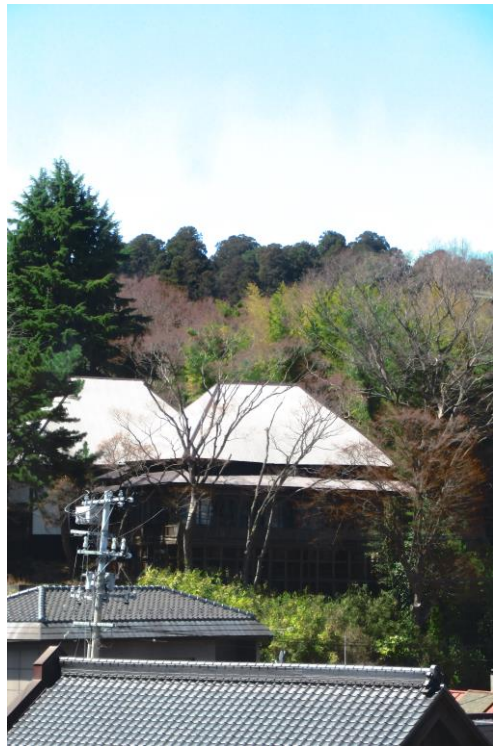
壱番館から望む勝画楼。雨漏り対策のため、屋根全体がガルバリウム鋼板で覆われた（4月10日）
