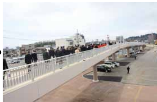
完成した避難デッキ
