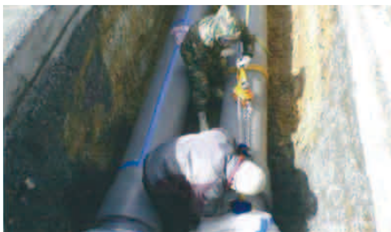
耐震管敷設工事の現場（提供：日本ダクティル鉄管協会）
