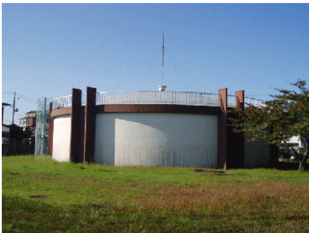
権現堂 PC 2 号配水池
