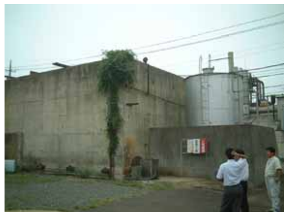
図5-3 既設貯蔵タンク
